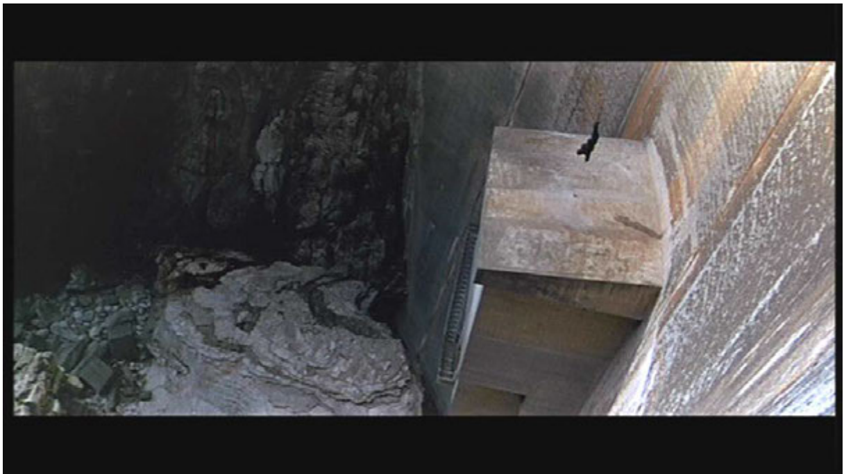
Abb. 8: Das Absenken mit Hilfe der Seilwinde in der Pistole
